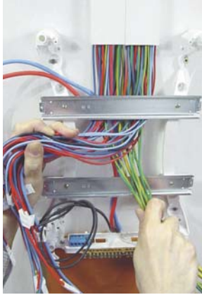
5 - Séparez les conducteurs de terre de leur ligne, puis regroupez-les vers le bas du tableau.
