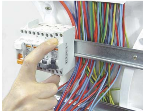
9 - Installez les protections sur les rails.
