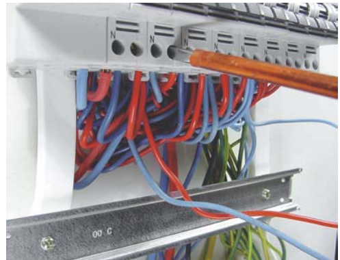
15 - Raccordez les lignes sous les protections.
