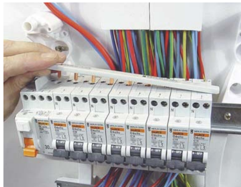
10 - Installez la barre de pontage de la phase.
