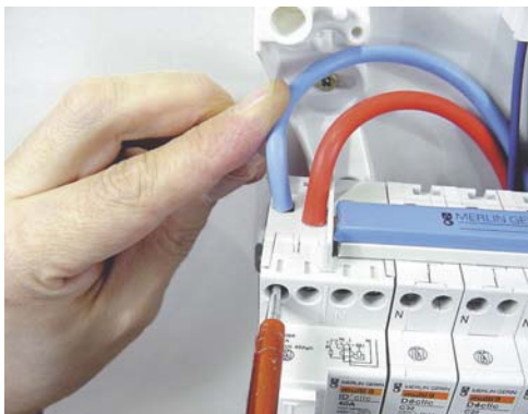
13 - Raccordez les fils provenant du disjoncteur.
