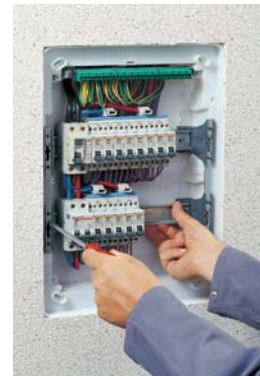
3 - Installez les modules et raccordez le tableau électrique.
