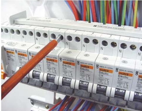
11 - Vissez fermement les vis des phases.
